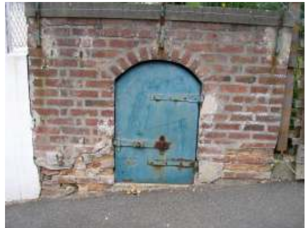
Fontaine rue du haut-Terre, alimentée depuis la source des Cours-Jean – Crédit photo : bessancourtblog.canalblog.com
