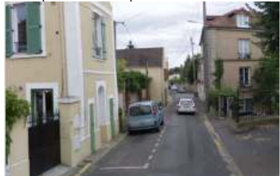
62 rue Pasteur : photographie d'une grande niche encastrée dans une façade, correspondant à une ancienne fontaine publique disparue.
