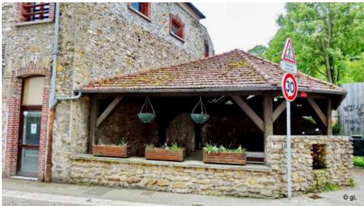
Le lavoir implanté au bord de la rue principale du village a été construit au début du XX ème siècle. La fontaine et l'abreuvoir à l'angle de la « Petite ferme » furent construits vers 1858. Crédit photo : Astrorail
