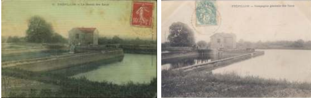
Réservoirs et usine de pompage construits par la Compagnie des Eaux en 1909, à la limite de Frépillon et de Bessancourt.
