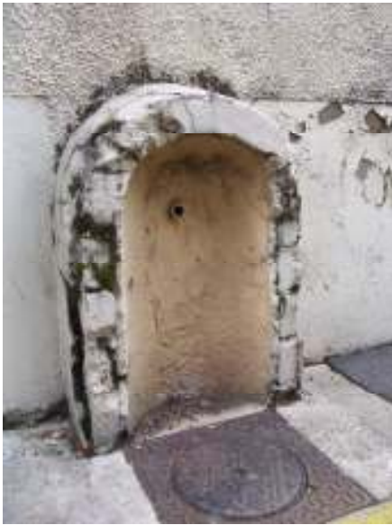
A gauche, ancienne fontaine au droit du 20 rue du Ru Crédit photo : Francis Cahuzac-CFPPHR.
