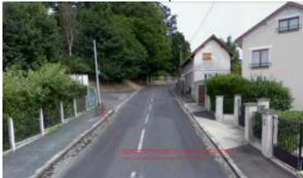
Traces de résurgence de l'ancienne source qui se trouvait à l'angle de la rue de Chauvry et du chemin des Claies.
