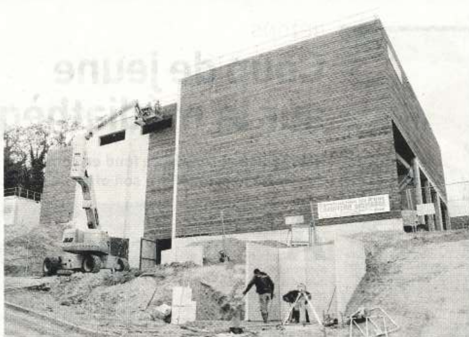
Encore en travaux, la chaufferie biomasse doit démarrer au mois de janvier pour alimenter 5 200 logements d'Ermont, Sannois et Franconville.
