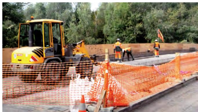
Préparation du socle pour les panneaux et du ferrailage.
