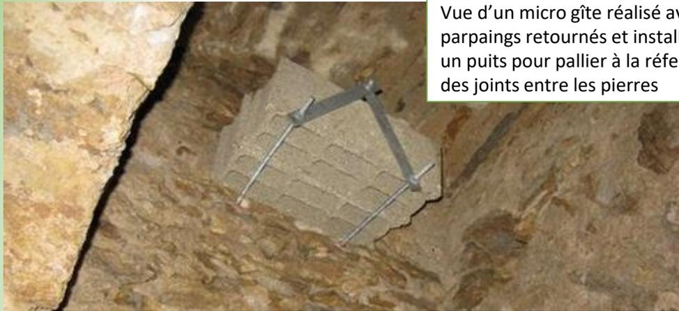
Vue d'un micro gîte réalisé avec des parpaings retournés et installé dans un puits pour pallier à la réfection des joints entre les pierres
