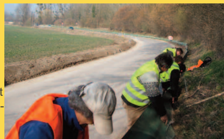
Installation du Crapauduc de la route de Baillon
